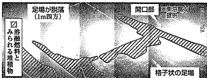
東京電力福島第1原発2号機の原子炉格納容器内部調査の画像。解析の結果、原子炉直下の足場が縦横約1m四方にわたりて脱落している。写真は同社が画像を合成(東京電力提供)
